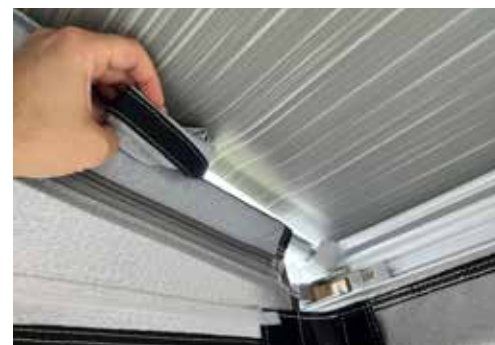
Aansluitkussen met klittenband tussen het dak en de zijwand.
