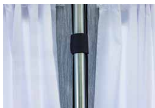
Verbinding van het tentdoek en de stokken middels klittenband (midden staander).
